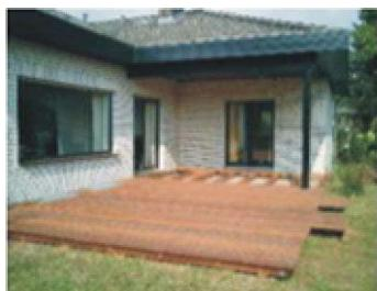
Nachdem alle Dielen befestigt und verschraubt worden sind, müssen diese wie auf der nächsten Abbildung zu erkennen, auf Länge gebracht werden.
