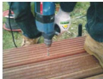
Vor dem Verschrauben ist es wichtig, dass Dielen und Unterkonstruktion vorgebohrt werden. Der Bohrer sollte 1 mm kleiner als die Schraube sein. Bitte verwenden Sie hierbei Edelstahlschrauben und schrauben Sie diese in den zweiten Steg.
