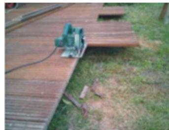
Die Dielen haben immer ein Übermaß von 2 – 3 cm. Um die Dielen genau auf Länge zu Kappen, sollten Sie eine Handkreissäge mit einem Widia Sägeblatt verwenden.
