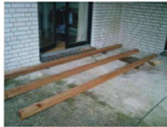
Die Unterkonstruktion ist mit einem Abstand von 40 – 50 cm parallel zu verlegen. Sie sollten zwingend Unterkonstruktion aus Hartholz verwenden.
