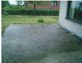
Der Untergrund sollte vor dem Verlegen der Unterkonstruktion ausgekoffert, mit feinem Splitt verdichtet werden und mit angefeuchtetem, neutralem Vlies ausgelegt sein.
