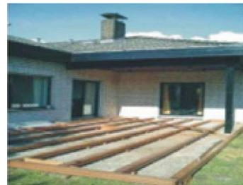
Die Unterkonstruktion sollte mit Winkeln und Flacheisen aus Edelstahl konstruktiv miteinander befestigt werden.
