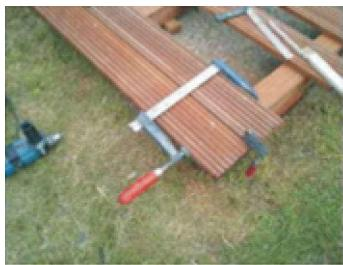
Beim Verlegen sollte die erste Dielen befestigt werden. Etwas ungerade Dielen können mit Spanngurten oder einer Zwinge in die richtige Position gebracht werden.
